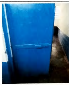
Foto 9: MODULO A Servicios sanitarios. Colocacion de piso en base de concreto en mal estado. Mantenimiento de puertas de metal
