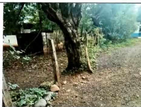
Foto 4: TRABAJOS EXTERIORES Sustitucion de cerco de vegetacion con alambre espigado por cerramiento de block
