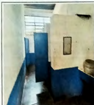
Foto 7: .MODULO A Servicios sanitarios mantenimiento de puertas de metal en mal estado y colocacion de azulejo en modulos de sanitarios
